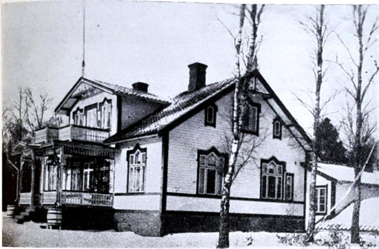
Carl Dams bostads- och kontorsbyggnad vid Boda.
